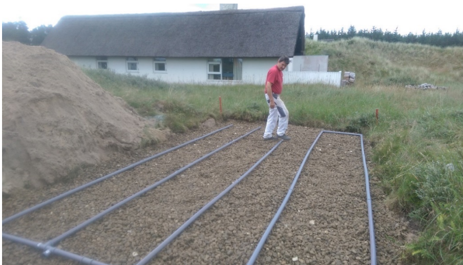
Sivedrænet er lagt oven på et lag af filtersand og grus. Bemærk at rørene i dette tilfælde ikke er lagt i frostfri dybde og derfor skal have lagt et betydeligt lag sand over for at ligge frostfrit.
