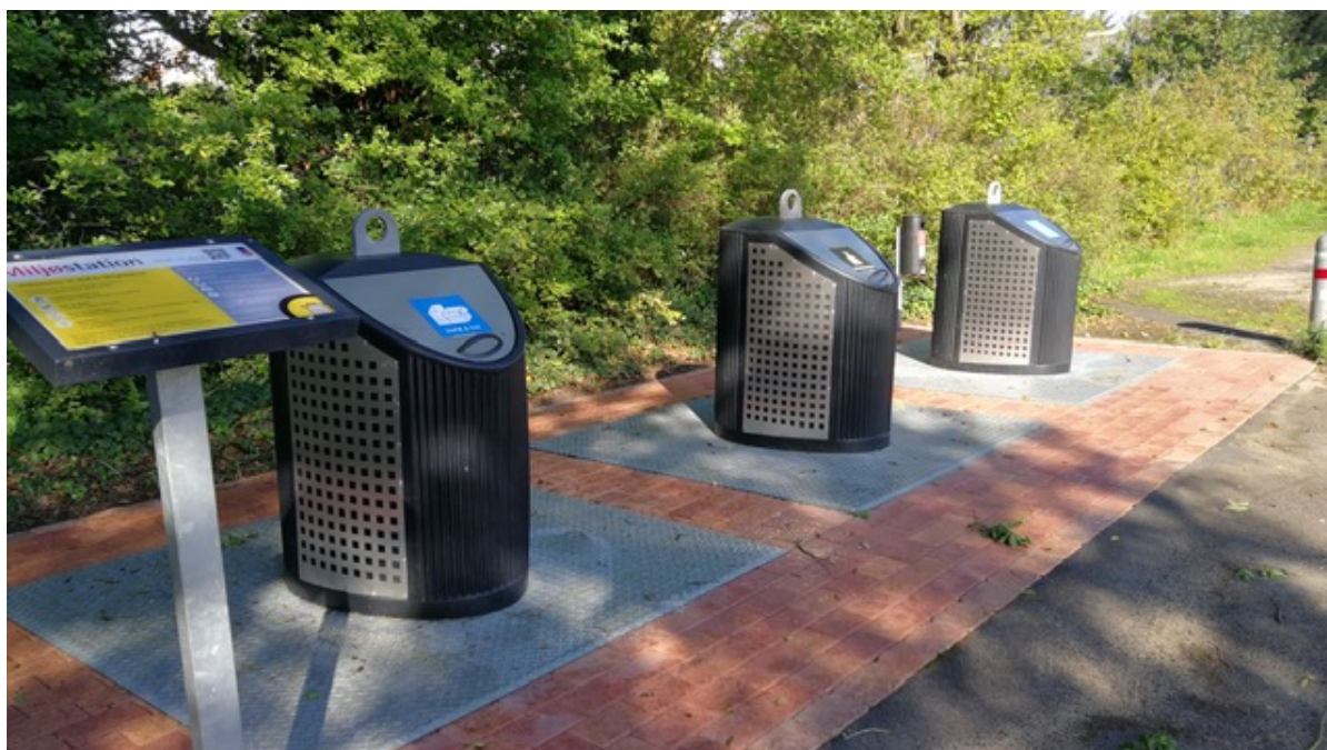
Eksempel på helt nedgravede containere
